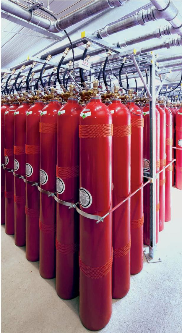
Oxeo Löschsyste $\ddot{u}$ me ermoglichen eine besonders kompakte und platzsparende Bevorratung des Lo $\ddot{u}$ schmittels.
